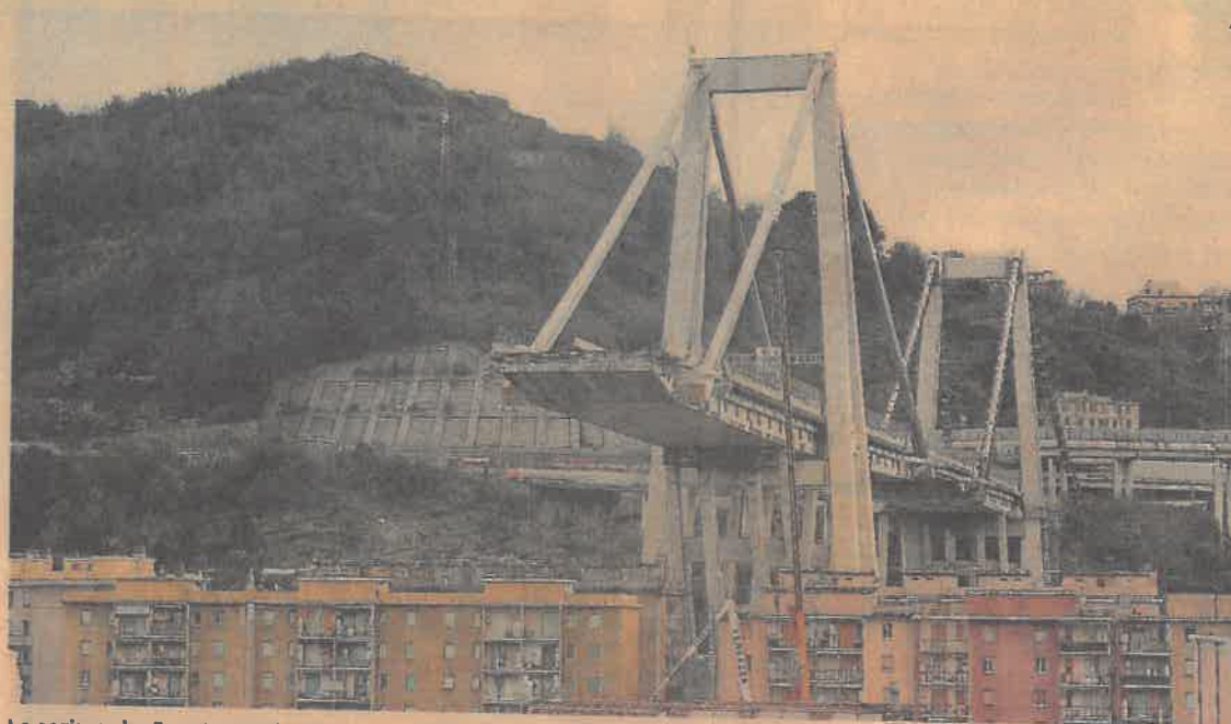
La cerimonia. Questa mattina la cerimonia d'inaugurazione dei lavori di demolizione
