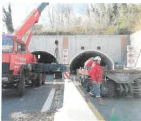
Il posizionamento dell'apparecchiatura
