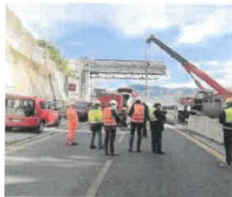
I lavori propedeutici al test
