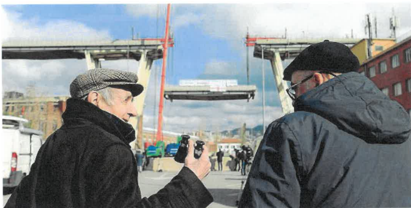
Avori Due genovesi assistono alla deposizione del primo troncone del Morandi: la demolizione è stata avviata a quasi 6 mesi dalla tragedia del 14 agosto (LaPresse)
