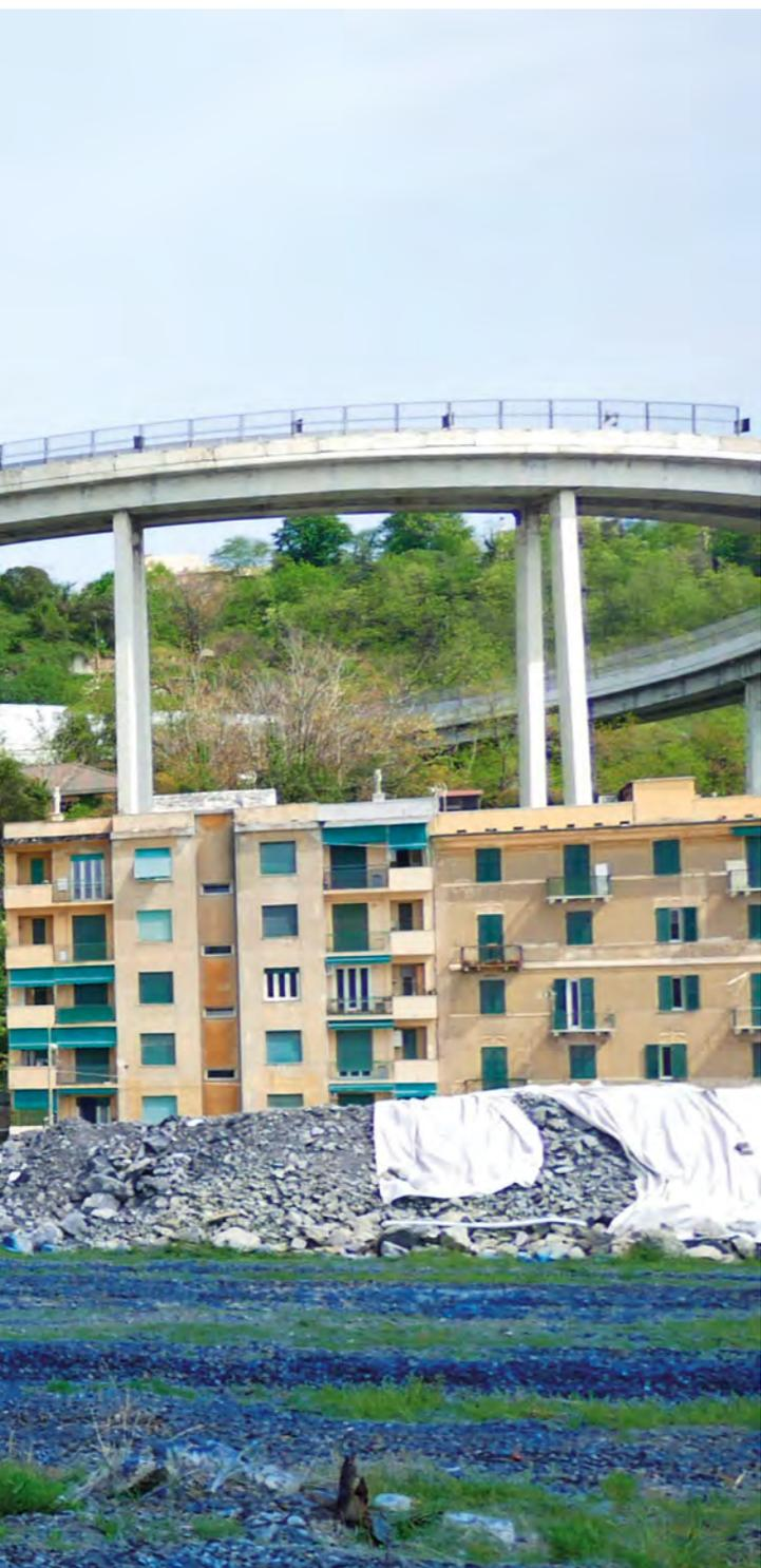
In vista della demolizione mediante esplosivo delle pile 10 e 11, per evitare che si potesse danneggiare l'autostrada A7, è stato necessario separare fisicamente la rampa di accesso lato nord smontandola con un autogru della portata di 400 tonnellate. Le travi rimosse sono state trasportate di notte lungo la A7 fino all'area di cantiere.
