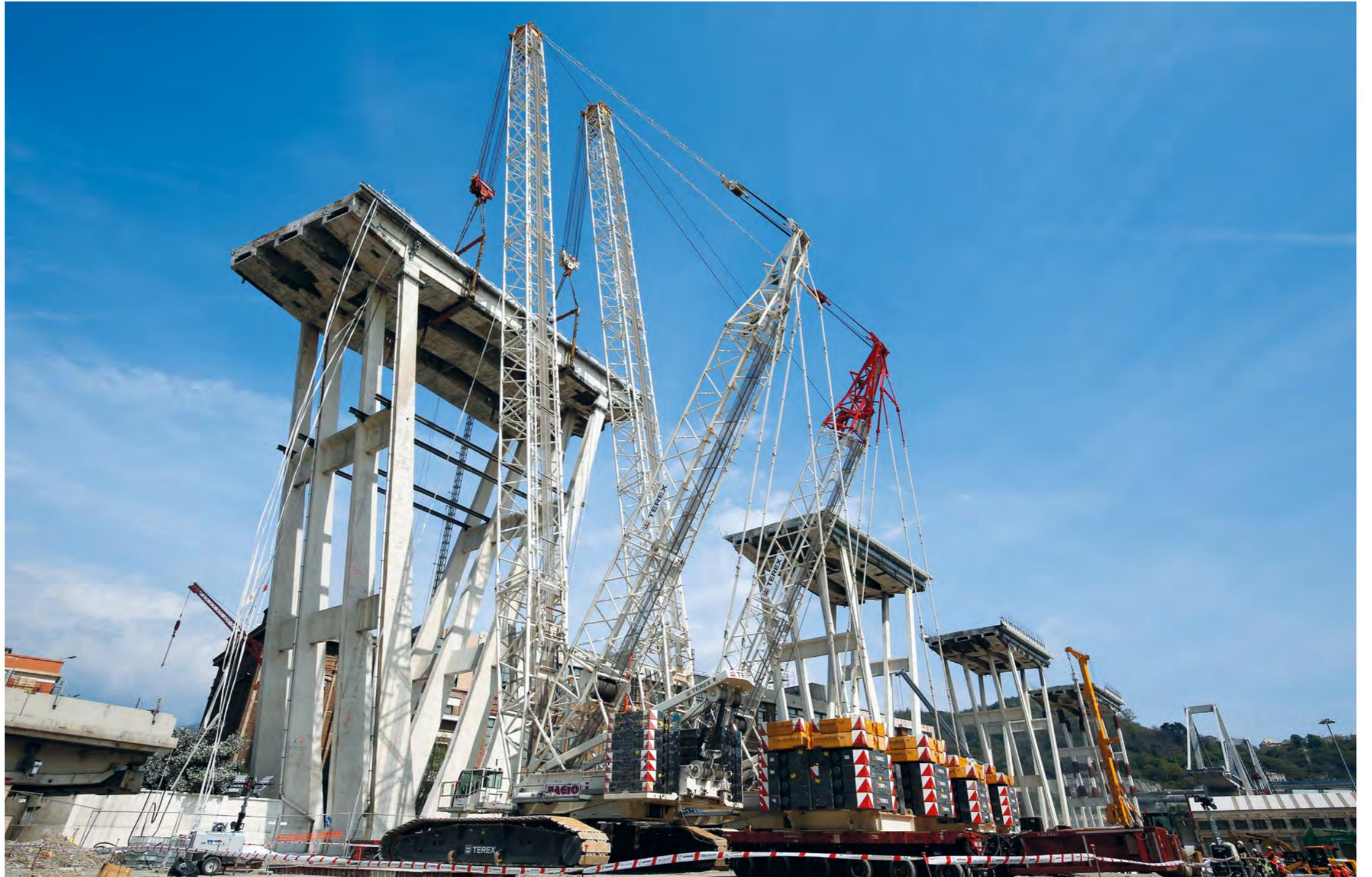
Lo smontaggio delle pile di Ponente ha richiesto, invece, l'impiego di due gru cingolate della portata di 600 tonnellate ciascuna, dotate di un braccio tralicciato di 70 metri, che hanno lavorato, in tandem, per lo smontaggio delle travi che componevano l'impalcato delle pile e, singolarmente, per lo smontaggio delle gambe.
